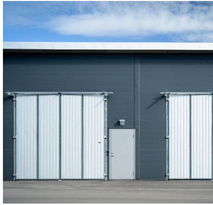
Foldeporter med sølvklakkert profilplate, sidebygning til en brannstasjon.
