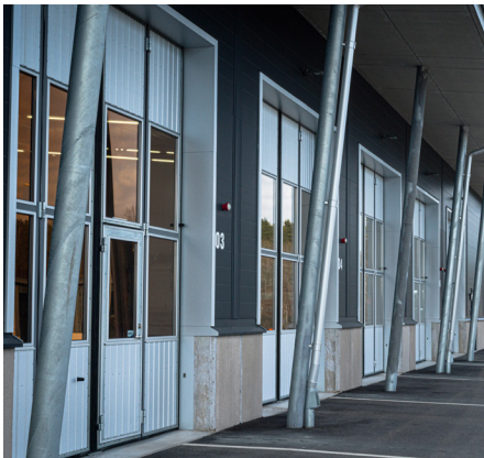
Foldeporter, firedelte, med innfelt gangdør for ekstra rømningsvei og gangpassasje.
