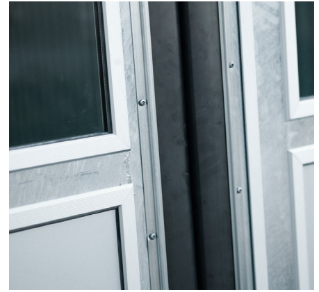
Glasspartiene er montert i solide lister av natureloksert aluminium.
