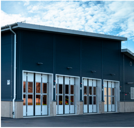
Motoriserte foldeporter med sølvklakkert profilplate og to rekke med glass.
