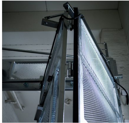
Strekkmetallet slipper gjennom lys og gir økt synlighet i garasjen, noe som er gunstig ved sluseløsning.
