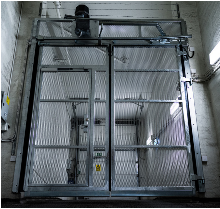
Doble porter med låsefunksjon og innfelt gangdør for evakuering.
