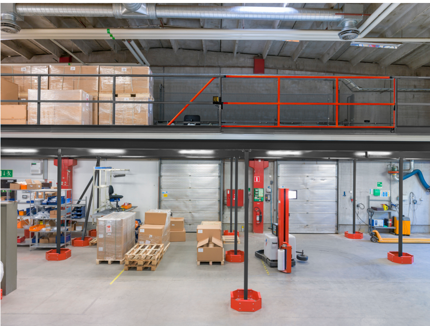
Opplastingsplass med motordrevet skyvegrind. Styring via radiosender
