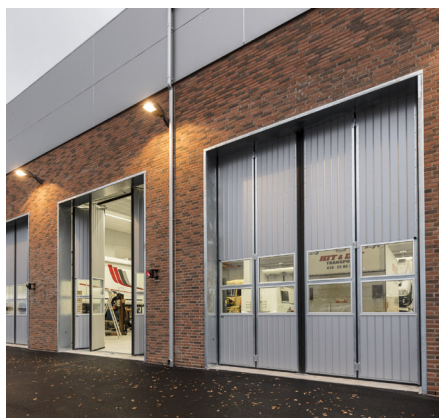
Sølvlakkert metallplate, firedelt, foldeporter med to rader glass.
