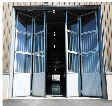
Foldeport, firedelt, med tre rader glass og gitter på innsiden.
