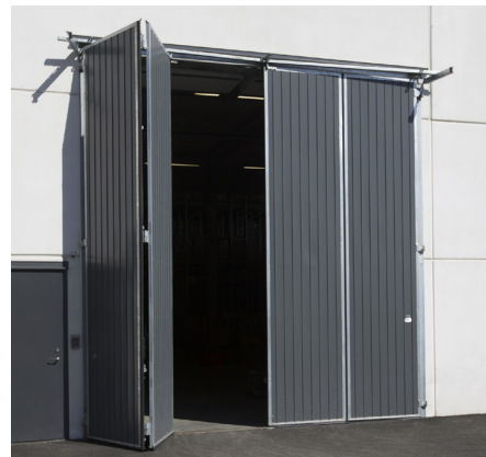
Foldeport med mørkegrå, lakkert metallplate, firedelt og utadslående.
